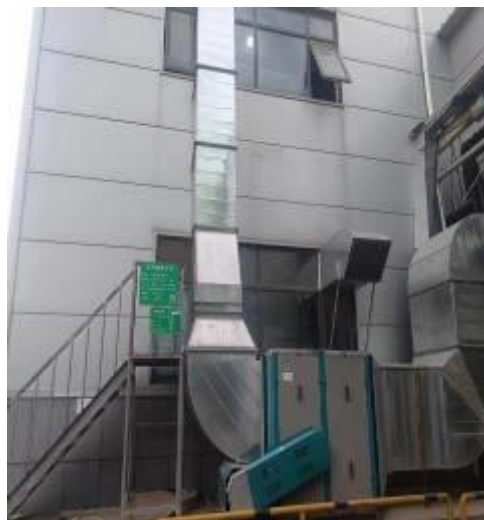
南区排气筒、废气治理设施及标识牌
