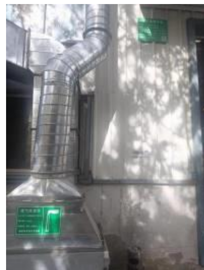
颗粒物废气处理设施及排气筒
