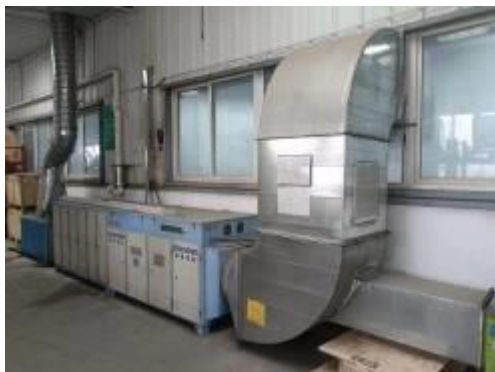
依托安达电子废气处理设施
