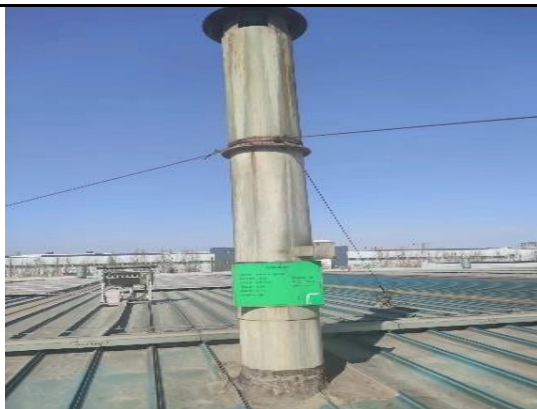
2号电镀线碱雾废气排气筒
