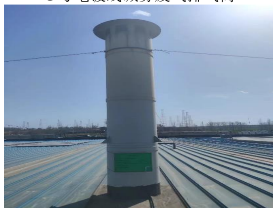
2号电镀线铬酸雾废气排气筒
