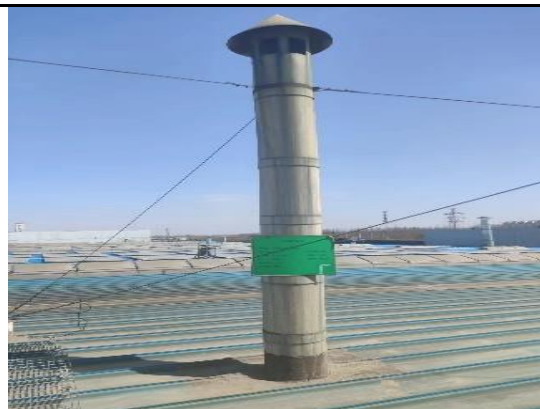
1号电镀线碱雾废气排气筒
