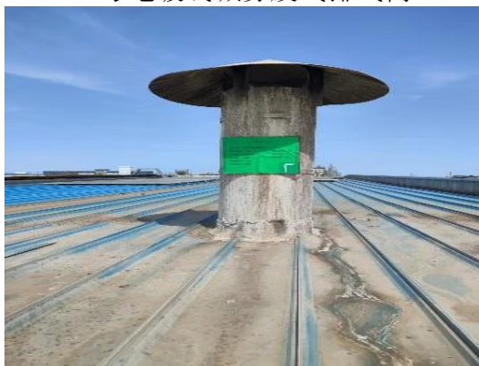
电泳线磷酸雾废气排气筒
