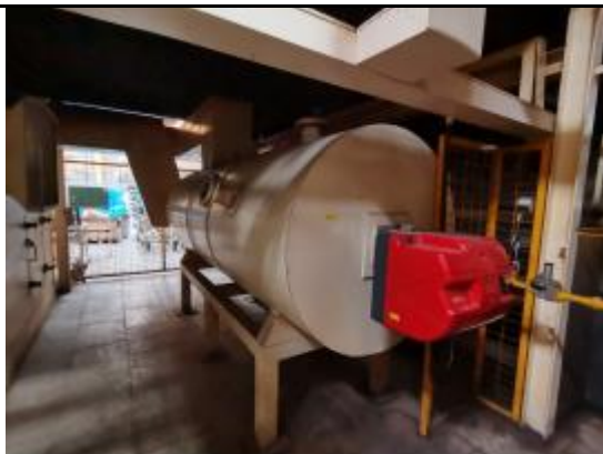
电泳线焚烧炉废气治理设施
