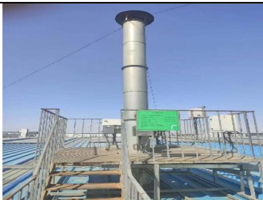
电泳线焚烧炉废气排气筒
