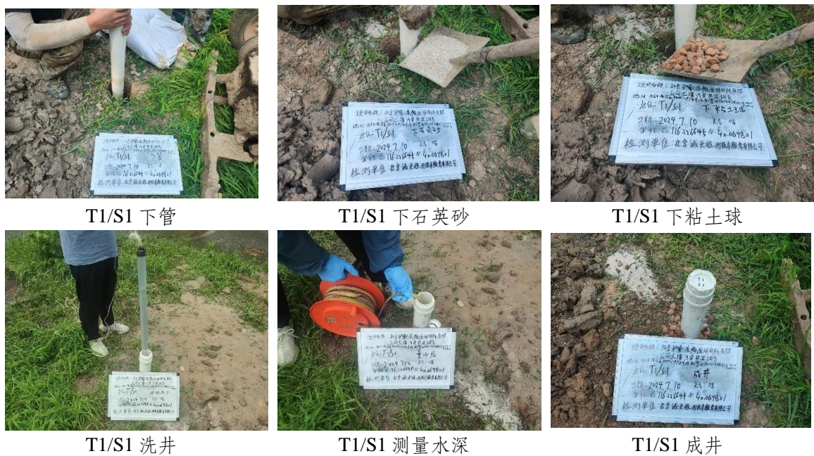
图5-4 地下水建井现场照片（部分）
