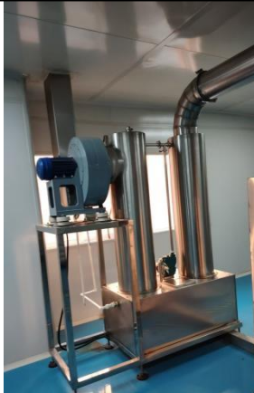
废气治理设施（水浴式除尘器）
